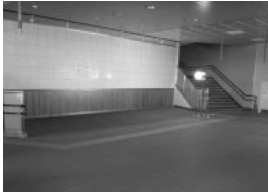
新幹線「筑後船小屋駅」2階の観光情報発信施設予定箇所
