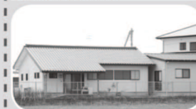
◀増築された松原小学校区学童保育所
