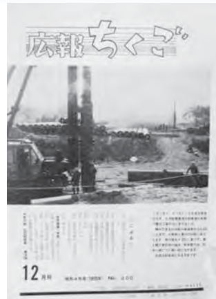
【表紙】九州縦貫高速自動車の矢部川橋の工事始まる 【主な内容】市内企業の設備投資進む
