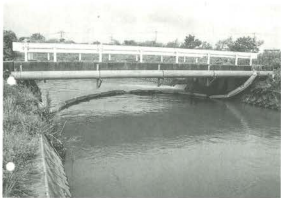
●7月17日、油流出事故のため、松永川にオイルフェンスが張られました
