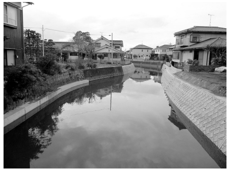
▲護岸工事が行われた倉目川
