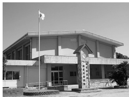
▲耐震工事を行った古川小学校体育館
