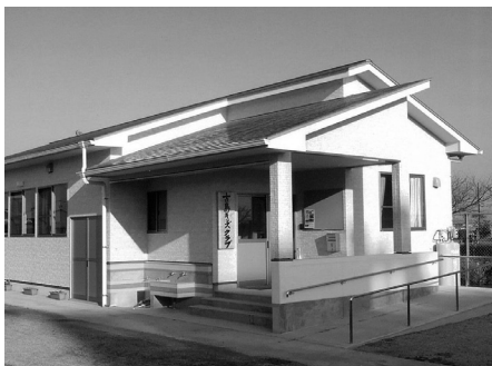
▲完成した古島小学校区学童保育所
