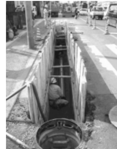
下水道開削工事
