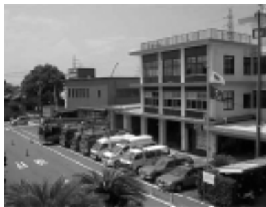
筑後市消防本部(署)
