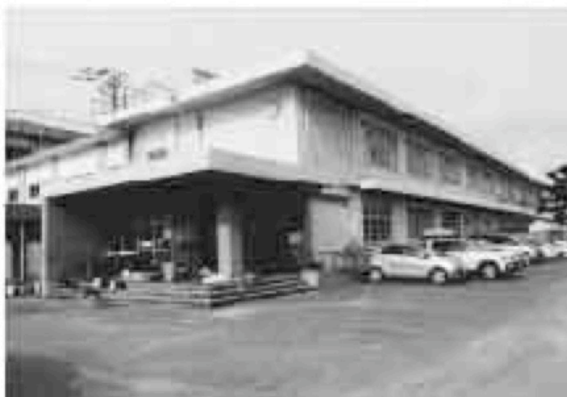
地震で倒壊の恐れ (耐震不足) と診断されている校舎
