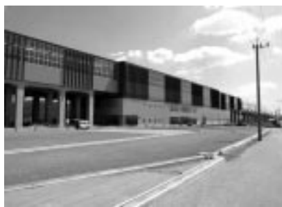
工事が進む新幹線筑後船小屋駅
