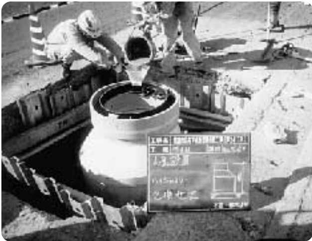
下水道事業の工事現場
