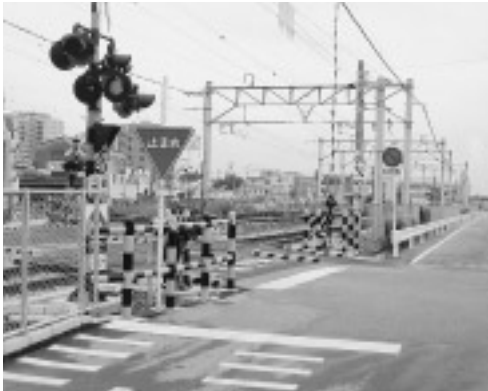
JR羽犬塚周辺整備 完成した山ノ井踏切
