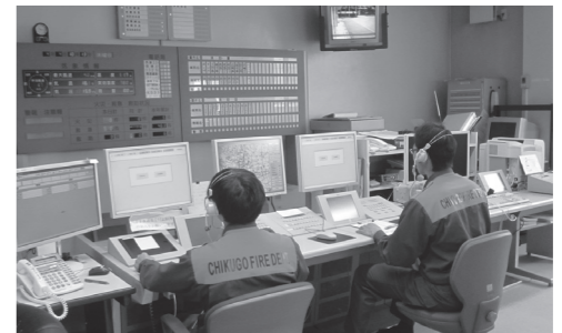
現在の通信指令室 (消防署2階)
