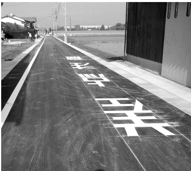
道路の舗装が進んでいる(長崎地区)
