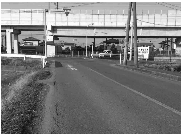
一日も早い安全策を！ 筑後中東側・踏切東変則交差点
