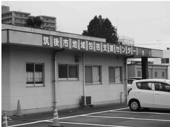
設置から8年が経過し重要性が高まる 「筑後市地域包括支援センターいきいき」
