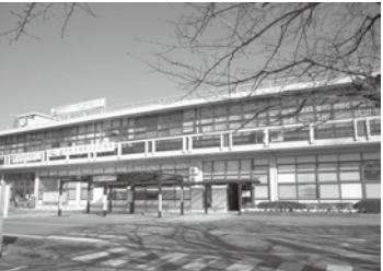
築60年が経過している市役所庁舎
