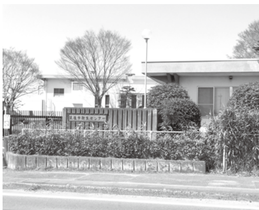
老朽化が進む高江の筑後市衛生センター
