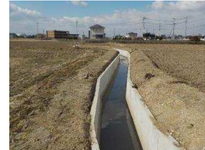
整備後の長浜地区水路
