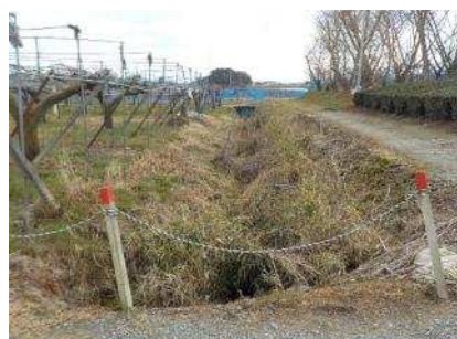
整備予定の前津地区水路
