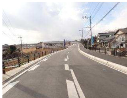
整備後の幹線道路
