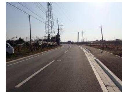
整備後の幹線道路
