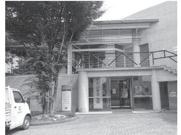
会議室やホールは地域にも開放しています
