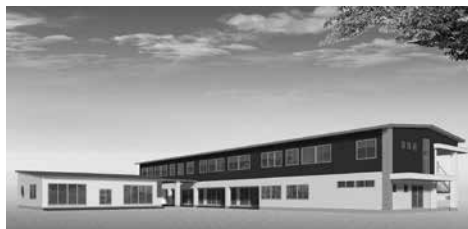
建設中の筑後保育所（完成イメージ）
