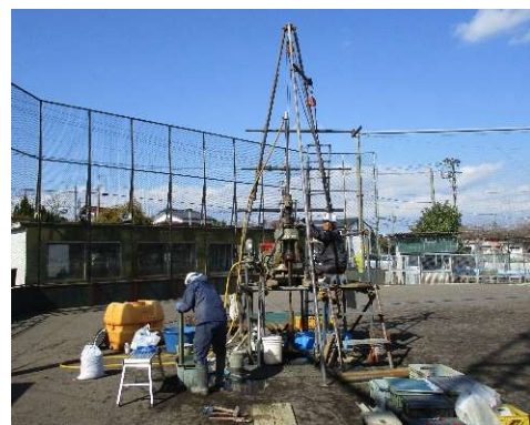
野球場ボーリング調査
