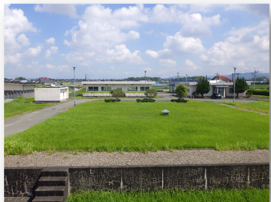
北牟田配水場（更新前）
