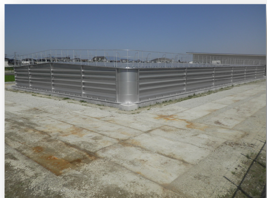
北牟田配水場（更新中）
