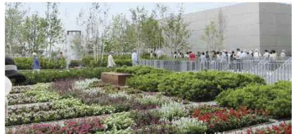
屋上緑化（町田市庁舎）
