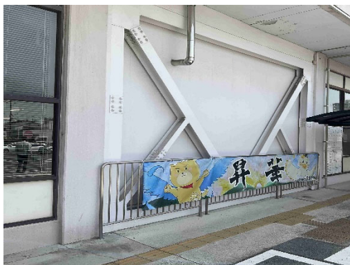
耐震補強のための筋交い
