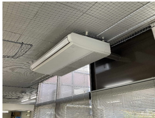
改修した空調機器
