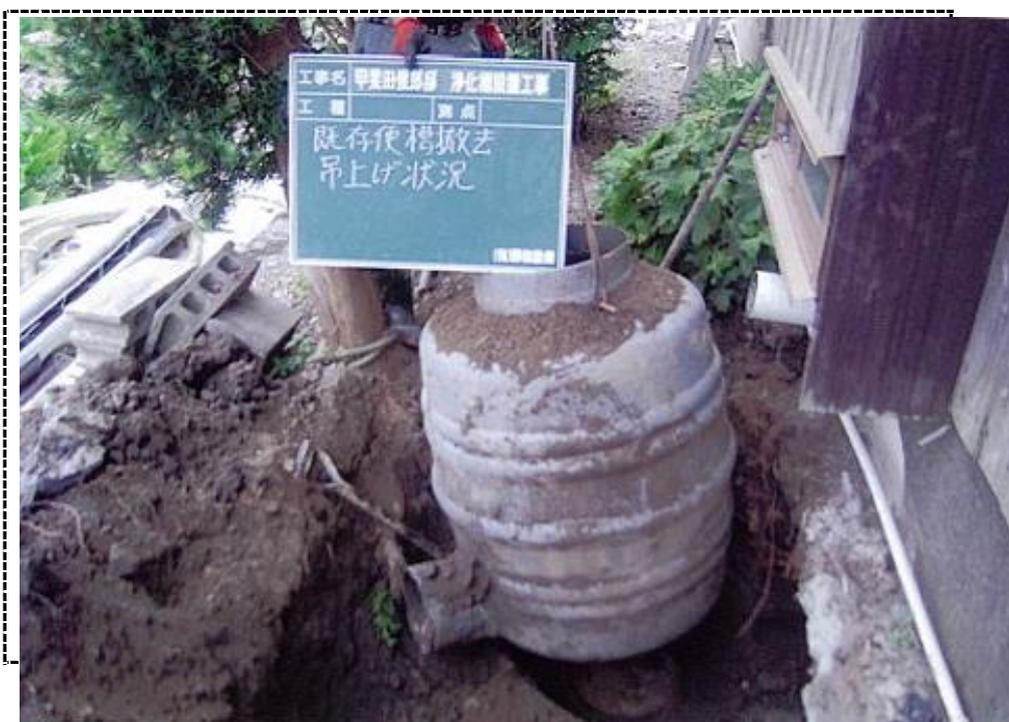
写真（転換－３）【既存設備の撤去状況】
