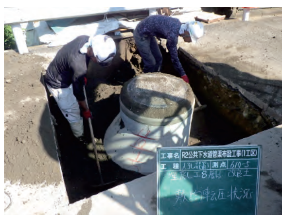
公共下水道管渠布設工事(推進、マンホール)
