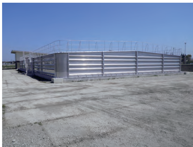
北牟田配水場 配水池
