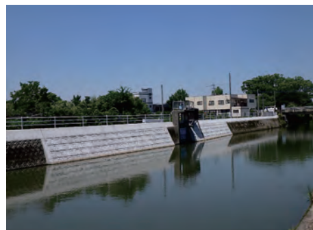
市営河川倉目川西牟田町地区緊急治水対策工事
