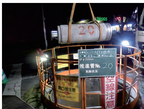
公共下水道管渠布設工事(推進、マンホール)
