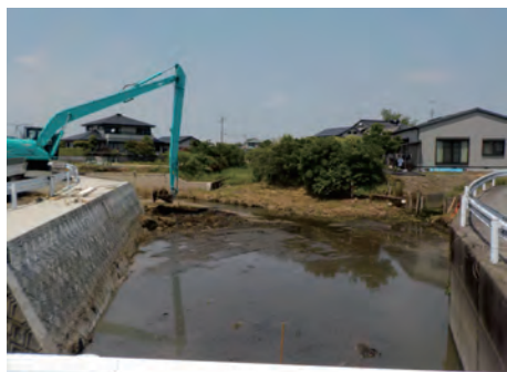
市営河川城崎川緊急浚渫工事
