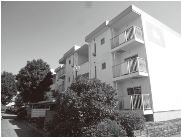
火災により損傷した久富団地
