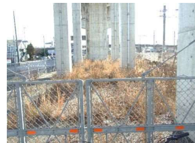
③駅南南側高架下〔未利用〕 土地所有者：九州旅客鉄道(株)
