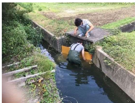
高い堰板の設置
