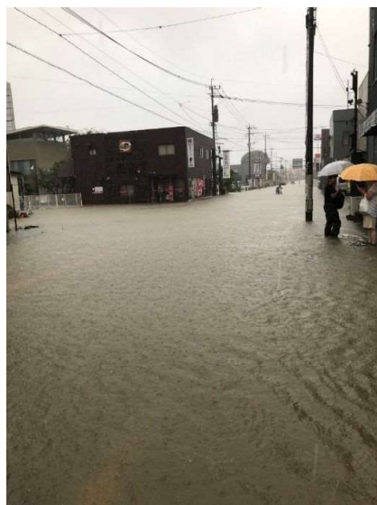
③国道 209 号の浸水状況
