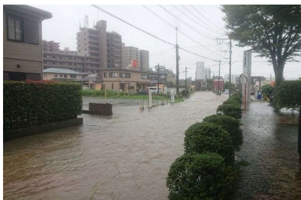
②市役所周辺の浸水状況
