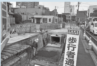
羽犬塚駅周辺事業の工事の様子
